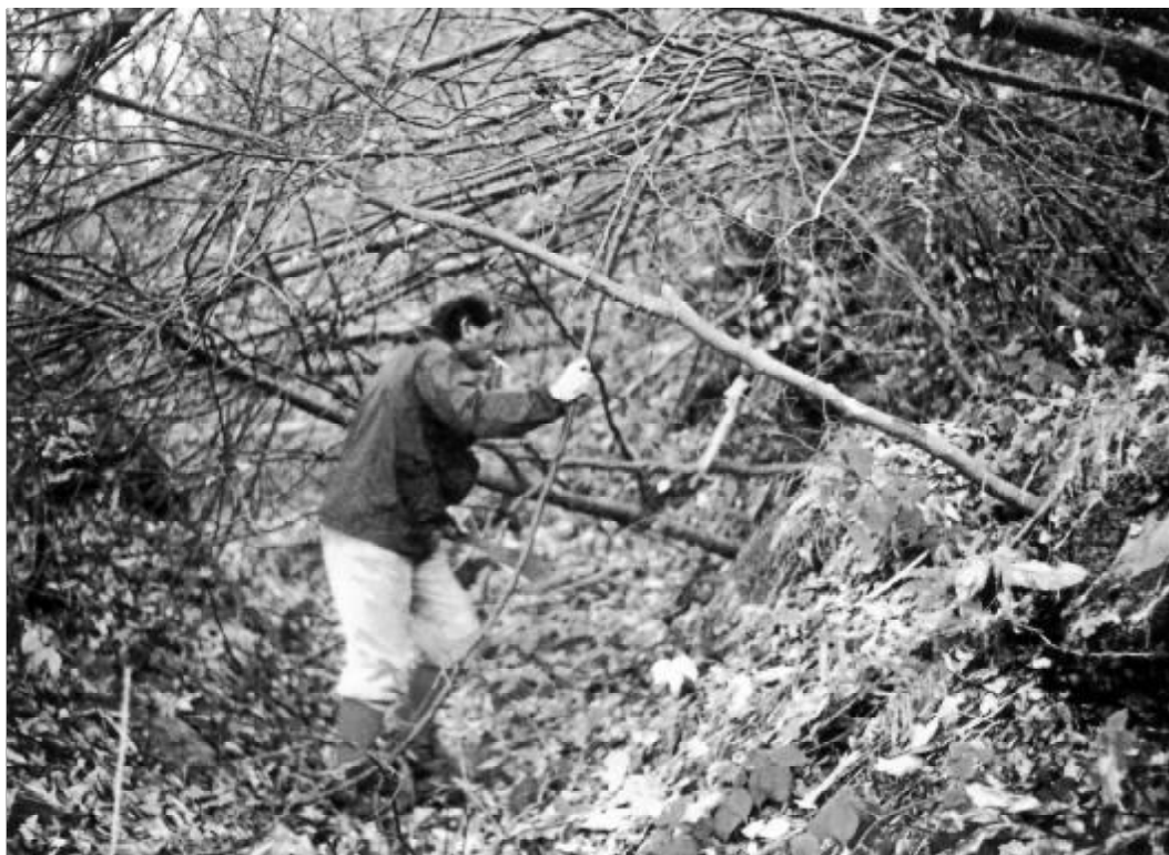
Lavori sul sentiero "dell'Acqua Caduta". Foto di Olindo Manca
